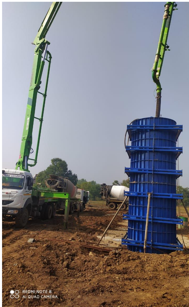
Pouring P2 pier shaft@ 352+281
